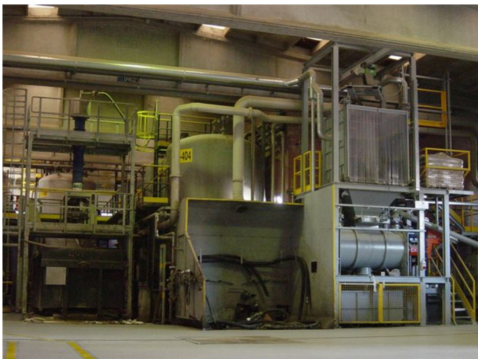
Figura 7 - Vista d'insieme dell'impianto di trattamento chimico-fisico
