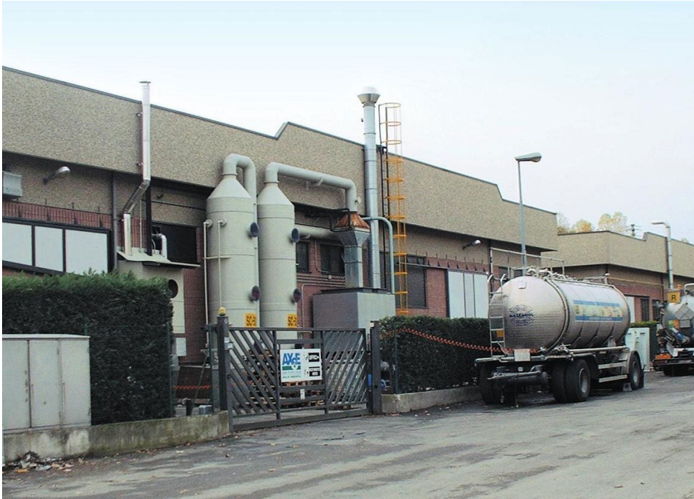
Figura 2 - Impianto di trattamento: ingresso carrabile
