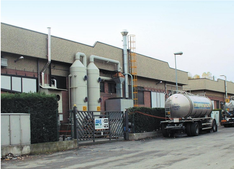
Figura 2 – Impianto di trattamento: ingresso carrabile
